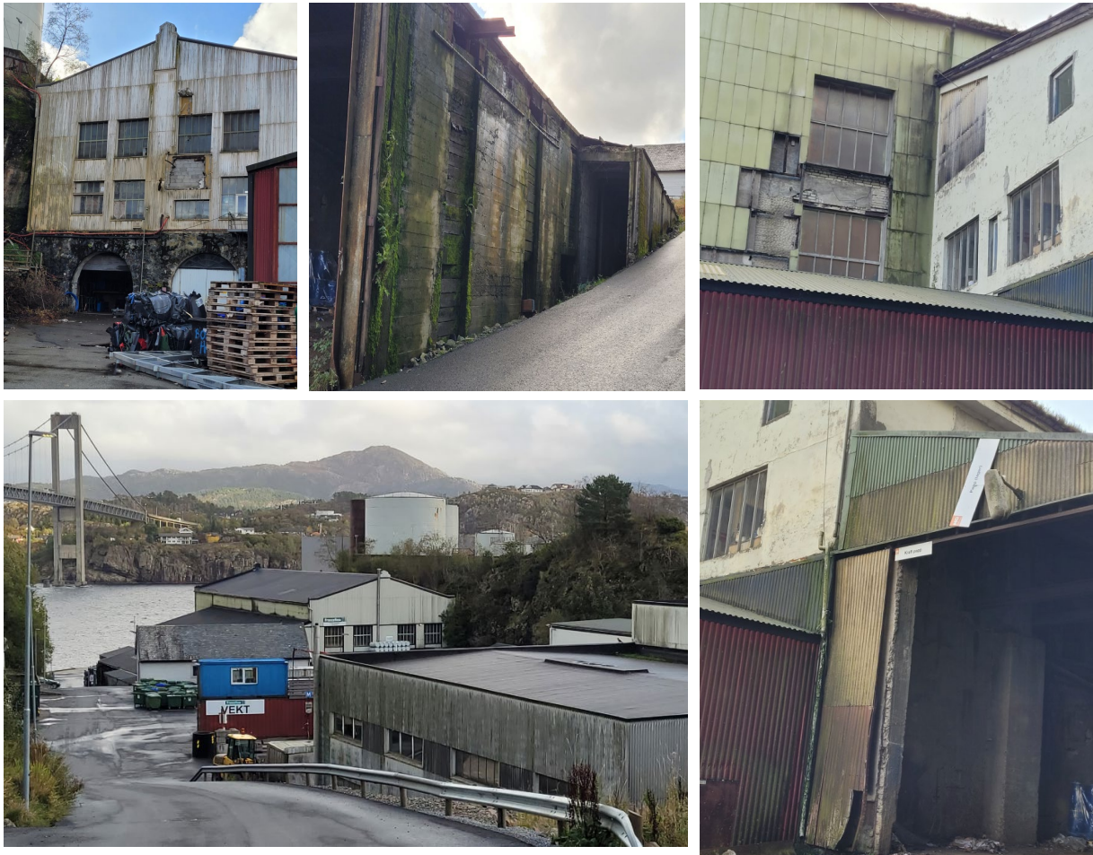
Figur 3: Nokre av dei eksisterande bygga innanfor planområdet har behov for vesentleg oppgradering. Foto: Multiconsult.
