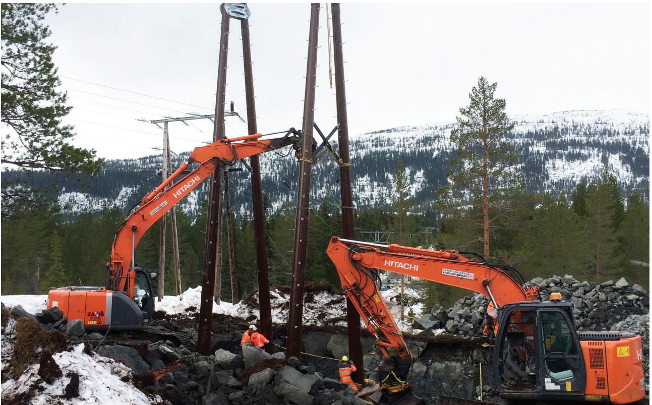
Montasje av kabelmast | Foto: Wiktor Sørgård, Multiconsult
