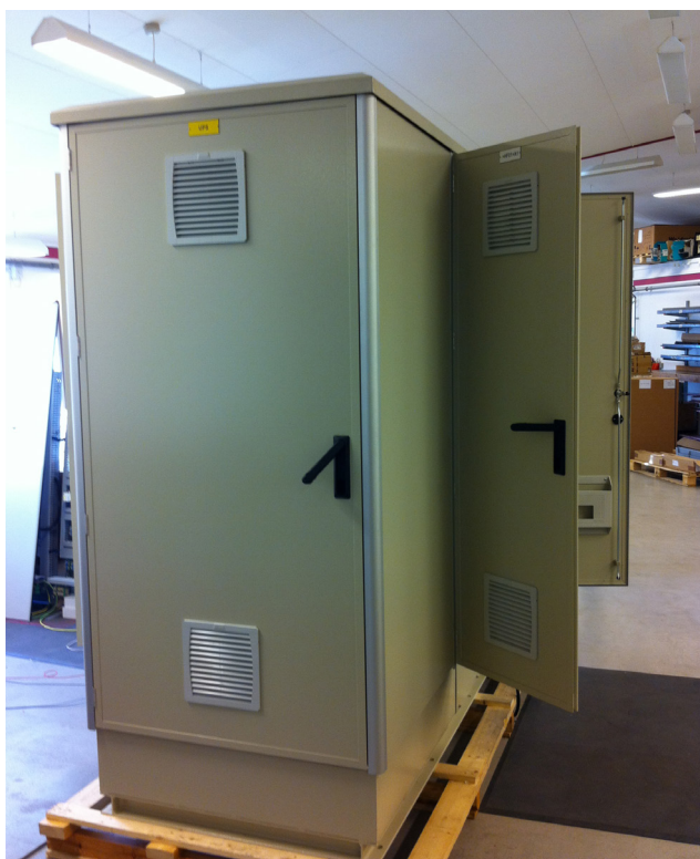
Fordelingen klare for installasjon | Foto: Lars Martin Rage, Multiconsult
