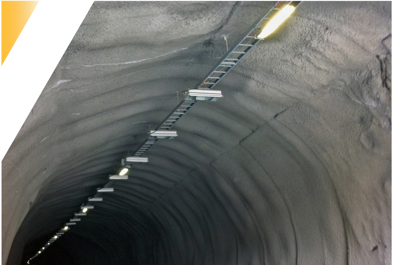
Røyrdalen tunnelen | Foto: Lars Martin Rage, Multiconsult
