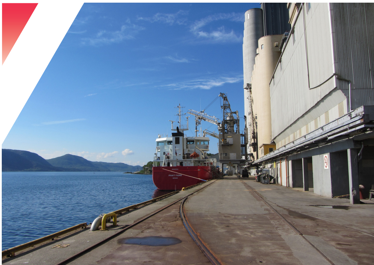
Kaikonstruksjon overside | Foto: Jon Vetlesen, Multiconsult
