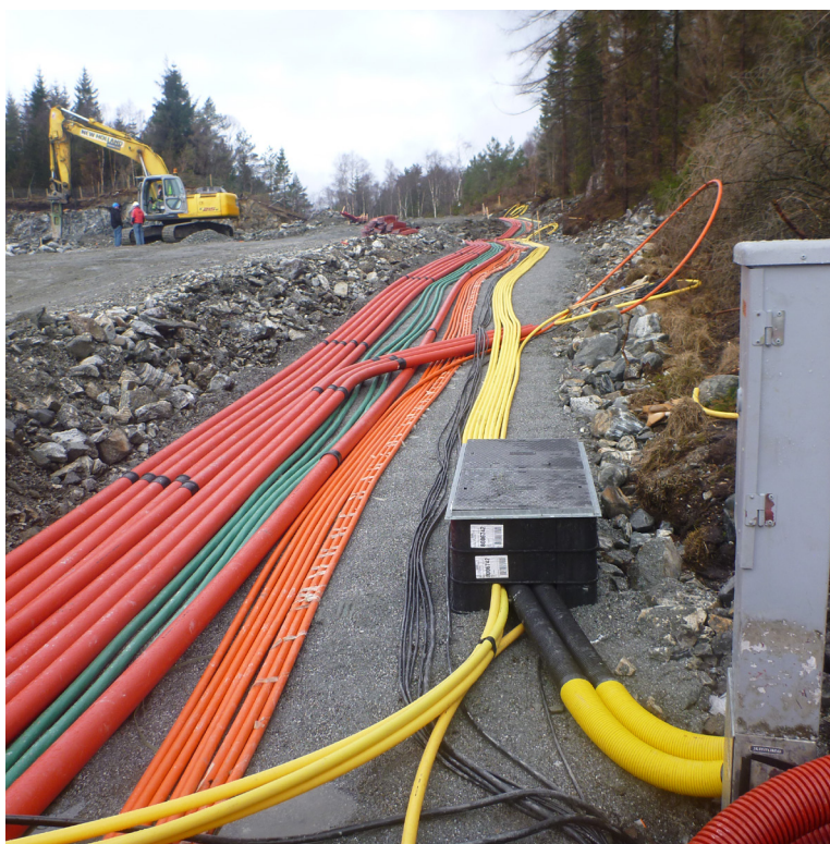
Illustrasjon - rør- og kabelgrøft | Foto: Multiconsult
